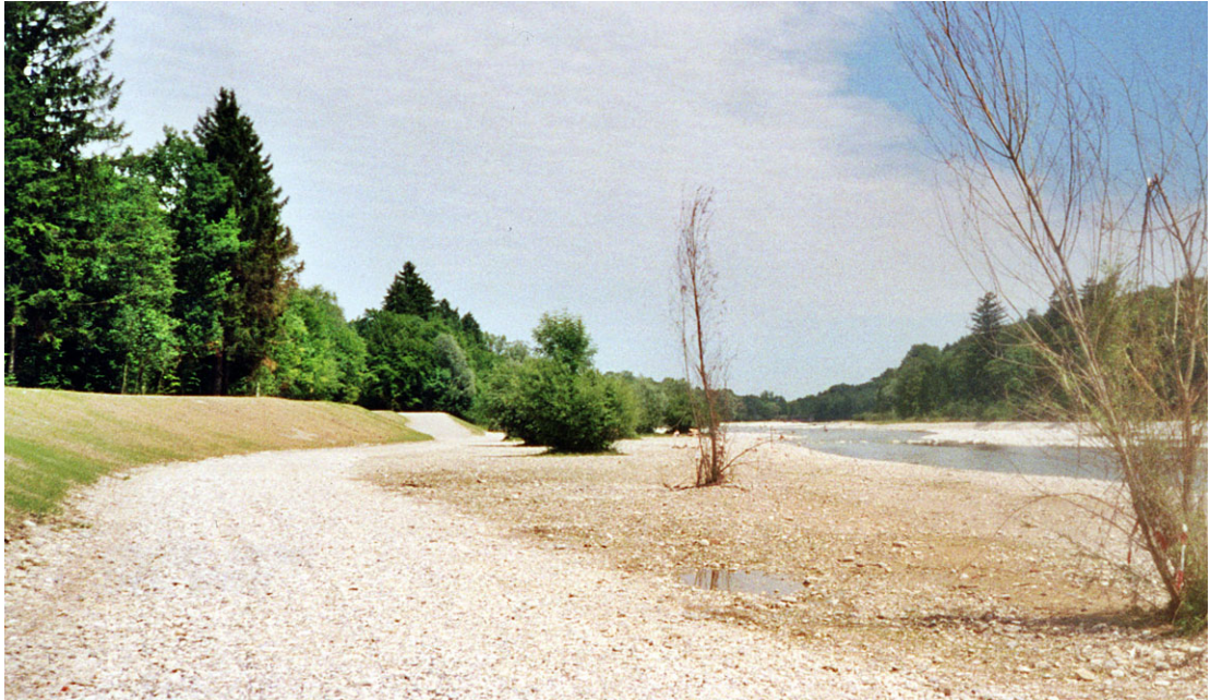
Initialbepflanzung nach Abschluss der Baggerarbeiten (an der Großhesseloher Brücke im Sommer 2001)
