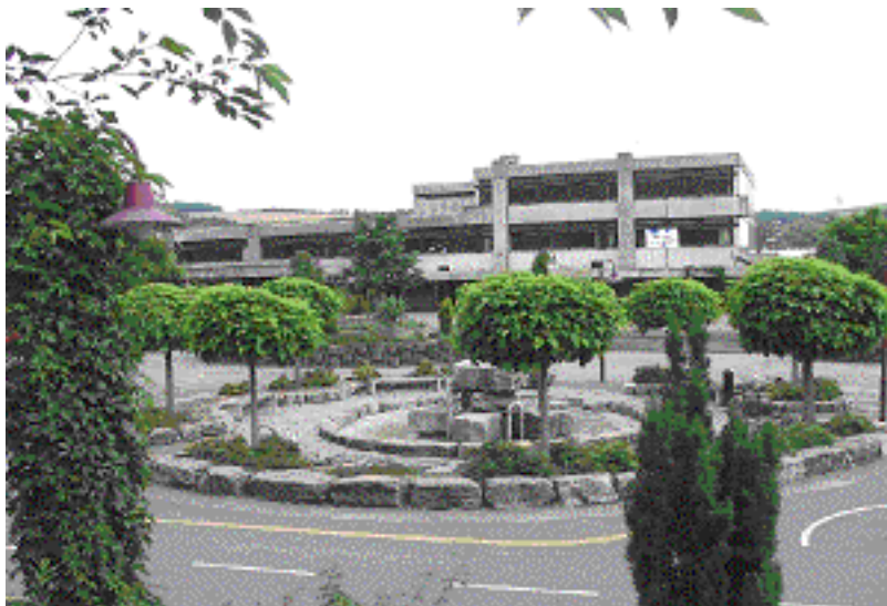
Bild 2: Ansicht der Realschule Krautheim
