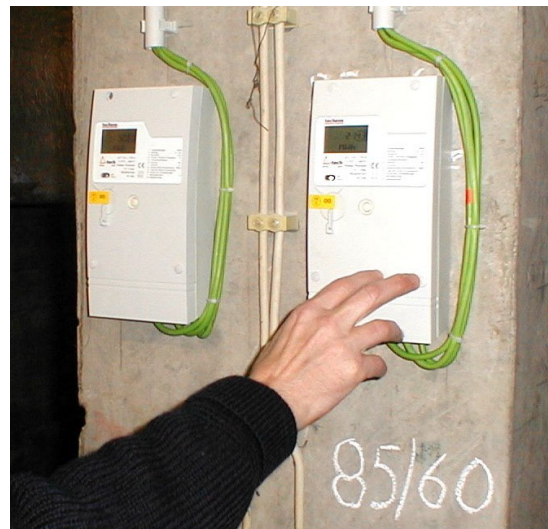
Abb. 15: Besichtigung der Zähler
