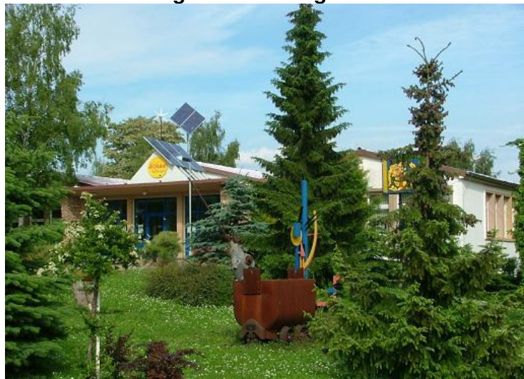
Photovoltaikanlagen in der Regelschule Roßleben
